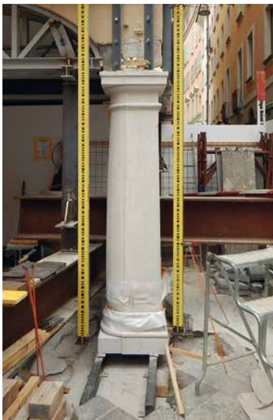
Piazzetta Maraini, sostituzione colonna © 2024 F&P
